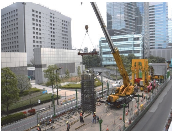
写真-3 港区道部地中連続壁工の状況
