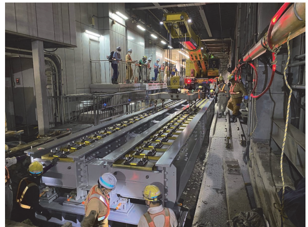
写真-2 操重作業車による工事桁架設状況 (隣接線使用不可能箇所)
