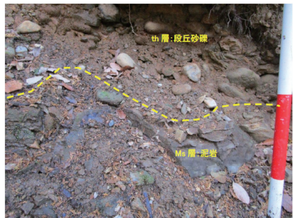
写真-1 泥岩層と段丘砂礫層の境界
