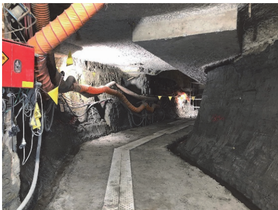
写真-4 導坑掘削状況
